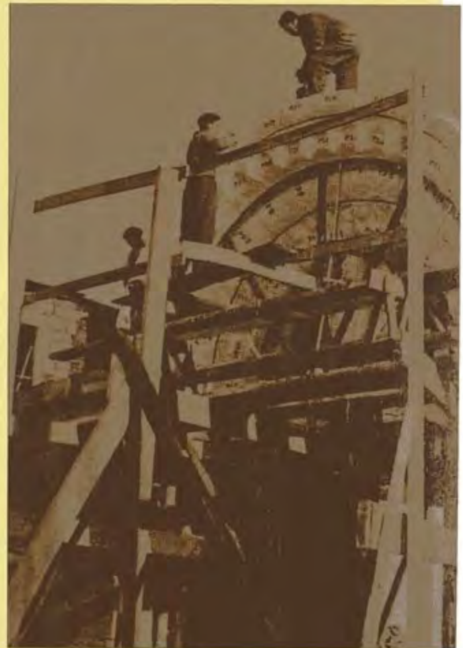
Portomarín. Iglesia de San Juan. Detalles de su traslado por anegamiento del embalse de Belesar.
