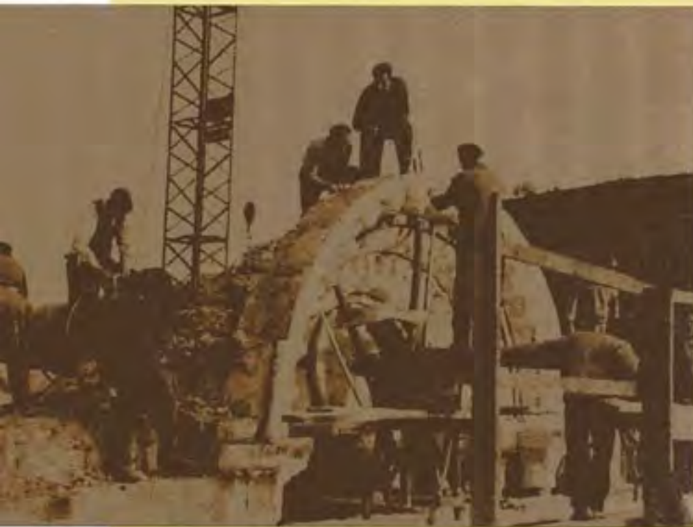
Portomarín. Iglesia de San Juan. Detalles de su traslado por anegamiento del embalse de Belesar.
