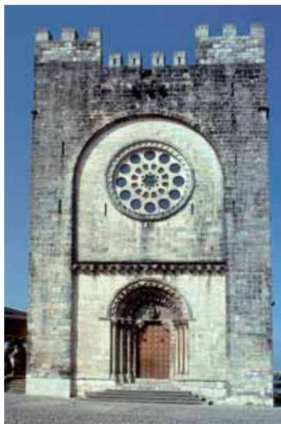
Fachada oeste. Estado actual. Archivo Fco. Javier Ocaña.
